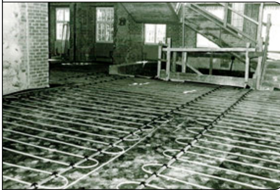
MB-Estrichsystem in der Eingangshalle
