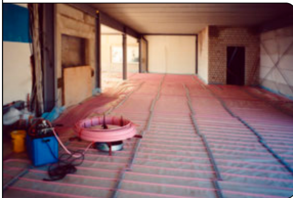
Verlegung der Fußbodenheizung
