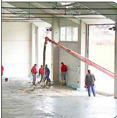
Einbringung des Fließestrichs
