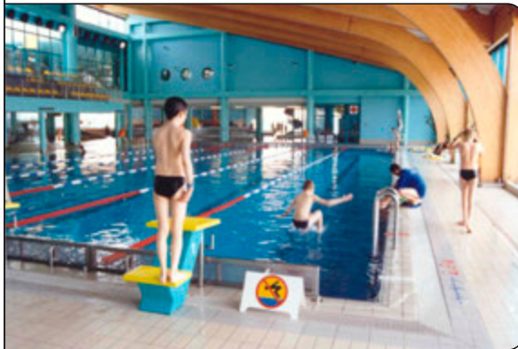
Beckenrand ohne Zugluft und störende Heizkörper
