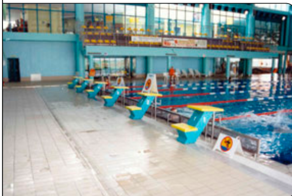
Beheizter Fliesenboden am Sportbecken
