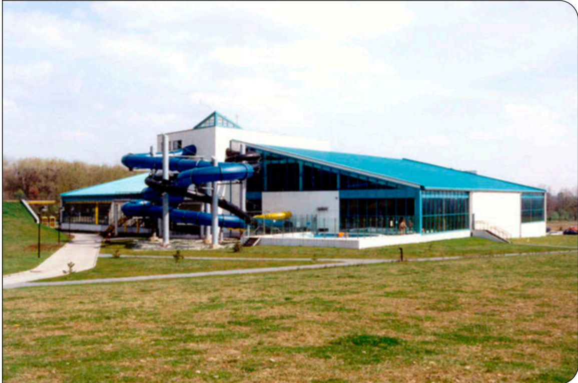
Außenansicht des Aquaparks
