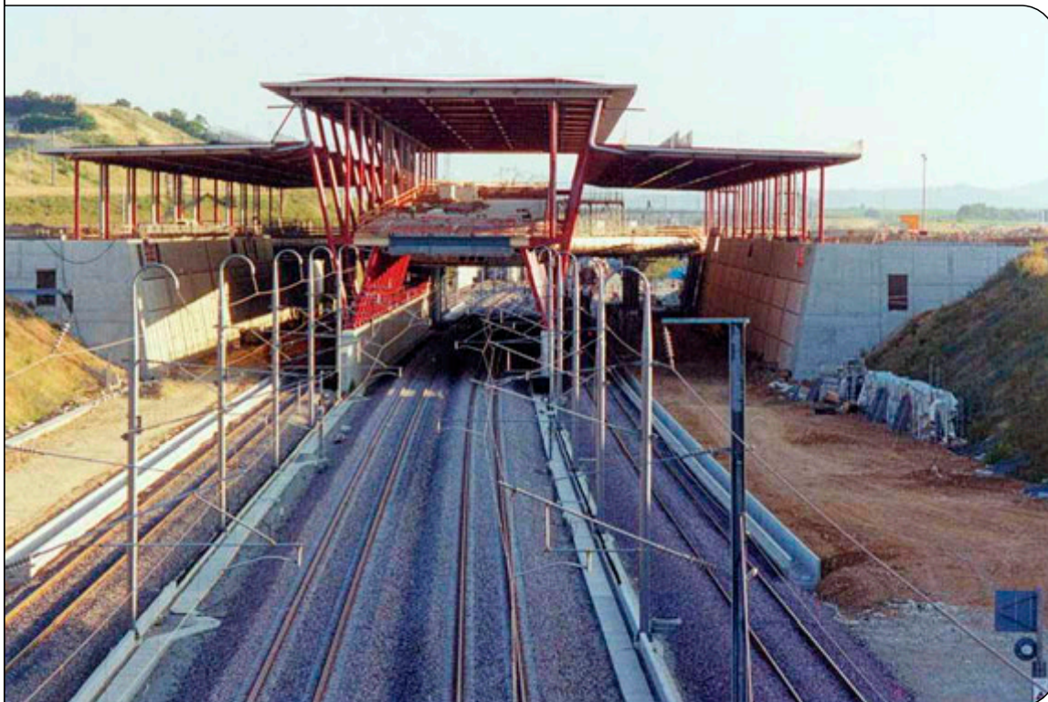
Bahnhof im Bau
