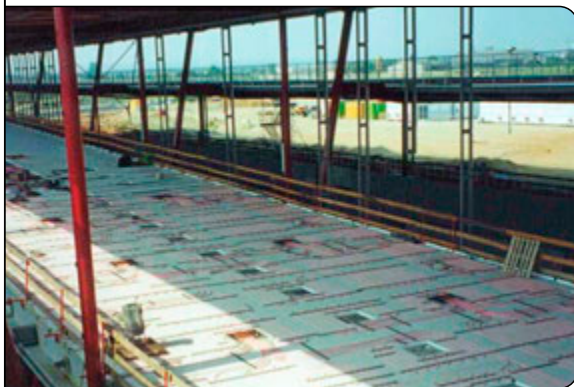
... vor der Einbringung des Estrichs
