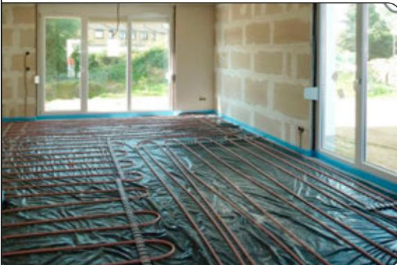
Fertig verlegtes MULTIBETON-System in einem Endhaus
