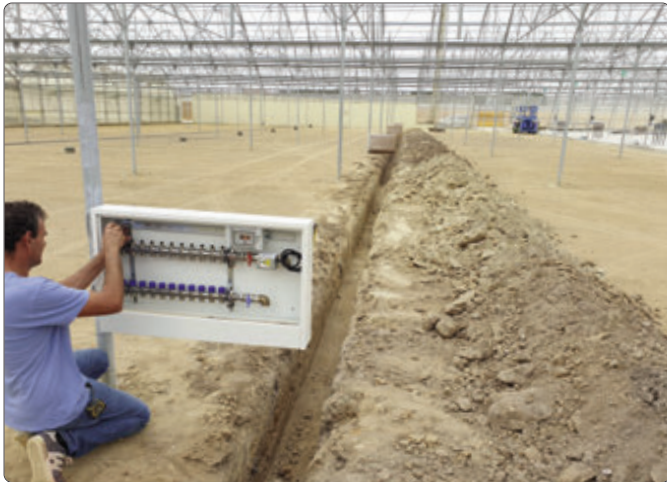
Verteilermontage
