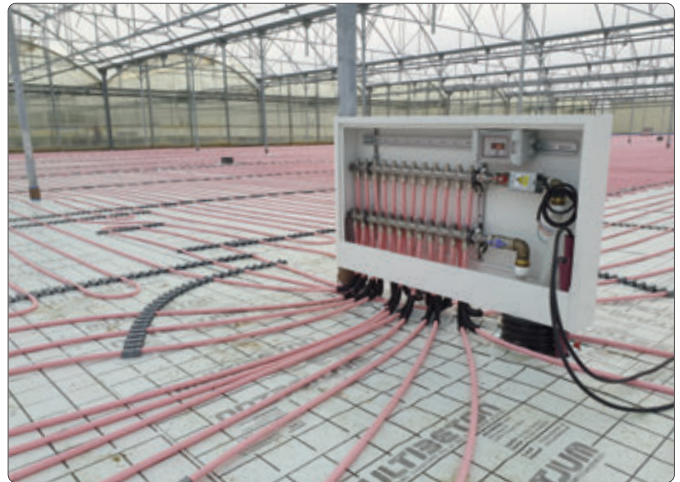
Fertiggestellte Verteilerstation
