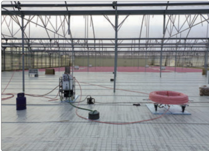
MB-Thermomontage auf der verlegten MB-PE-Folie
